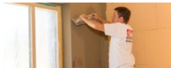
Armierungsgewebe mit mindestens 10 cm Überlappung einbetten und abschließend mit Klebe- und Spachtelputz überarbeiten
