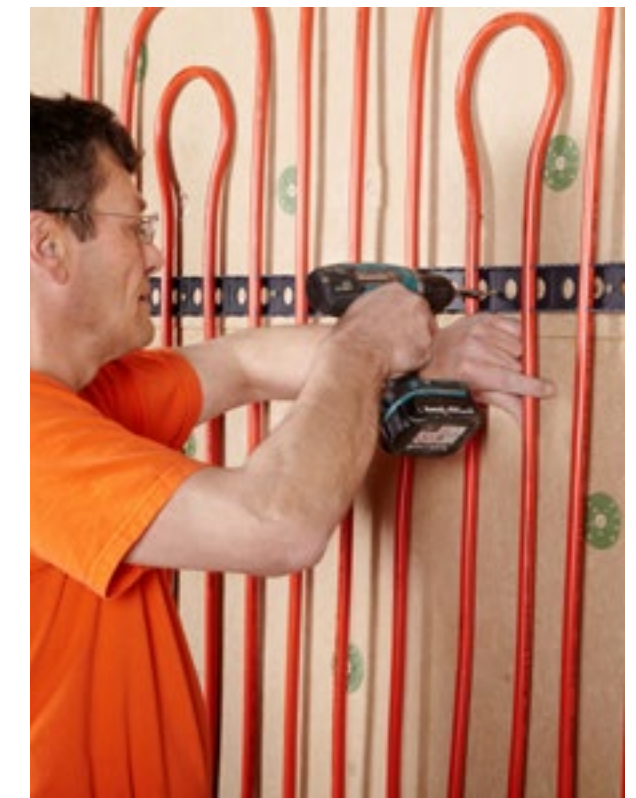
Klimaregister auf die Dämmplatte schrauben
