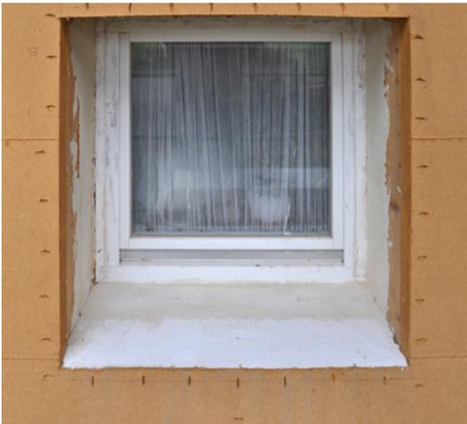
Glattstrich im Mauerwerksbau bei vorgesetzter Durio-Fassade
