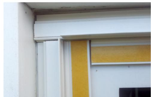
Wird eine Sturzplatte verwendet, so ist diese als erstes einzubauen. Gleiches gilt für das zugehörige Fensteranschlussprofil. Anschließend bauen Sie die Profile für die GUTEX Implio P Laibungsplatten ein.
