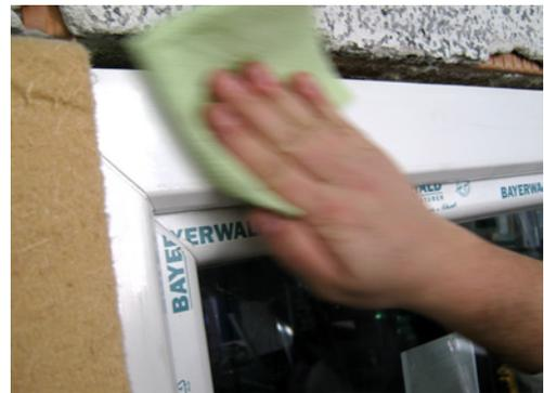
Eventuell vorhandene Gehrungsnuten im Bereich der Fensteranschlussprofile verschließen Sie vorab mit GUTEX Implio Dichtkleber.
