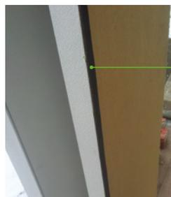
GUTEX Fugendichtband BG 1
